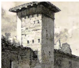
Une des tours des remparts de la ville de Moissac, construite vers 1480 et donc contemporaine de la nôtre. On y distingue les « corondats ».
